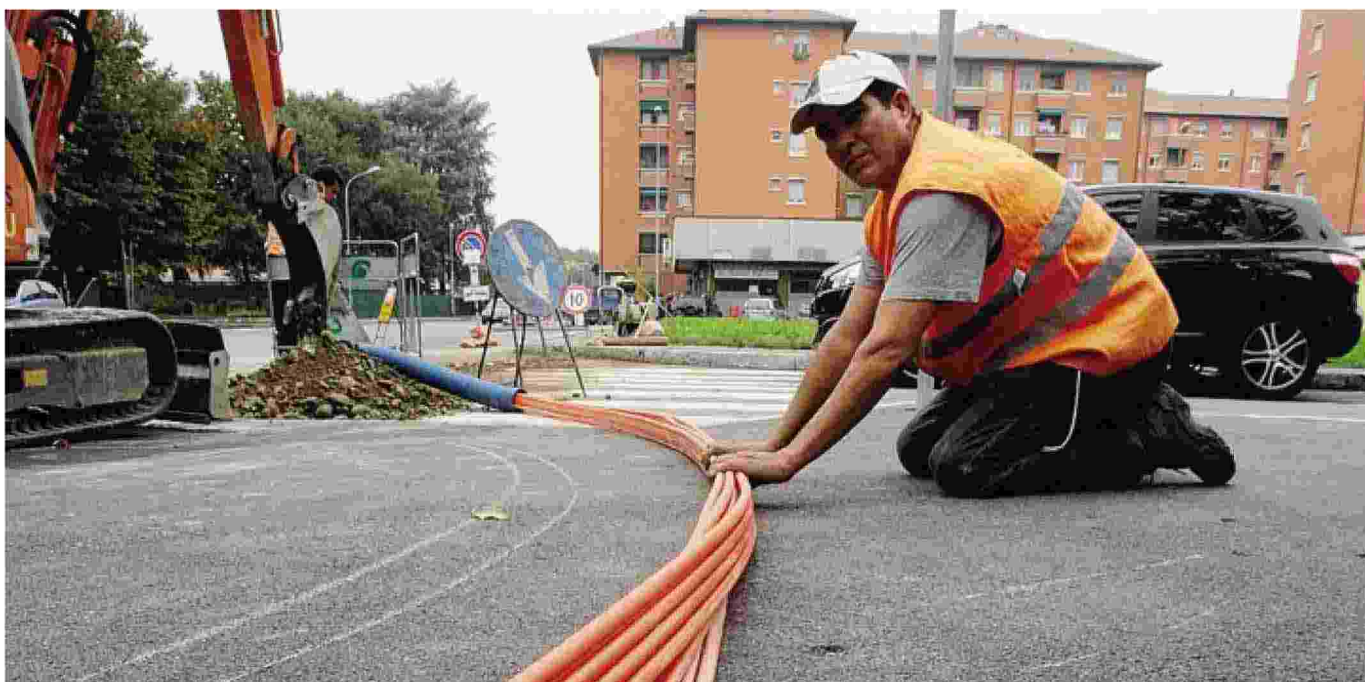
La posa dei cavi della fibra ottica a Monza
